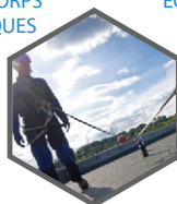
LIGNE DE VIE
