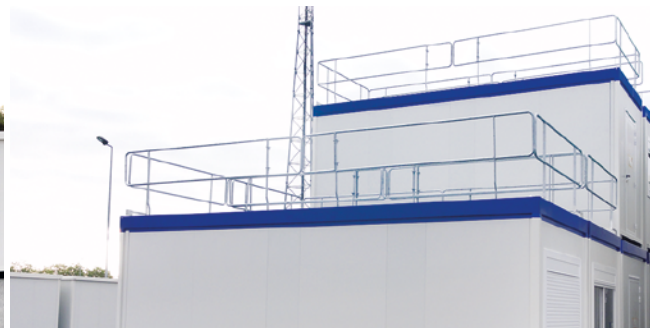
Garde-corps à demeure rabattables et relevables du sol.
