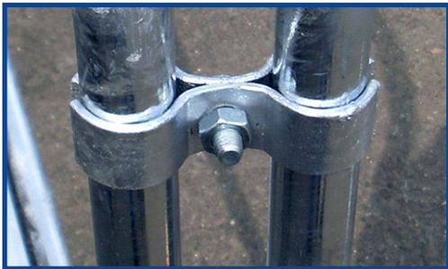
Assembler les éléments de garde-corps à l'aide des raccords, avec une clé de 17.
