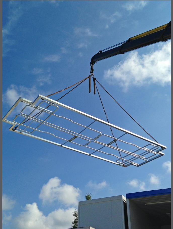
Intervention sur toiture à gauche. Elinguage d'un Modulogard version 9 m à droite. En bas, Modulogard version 6 m raccordé.
