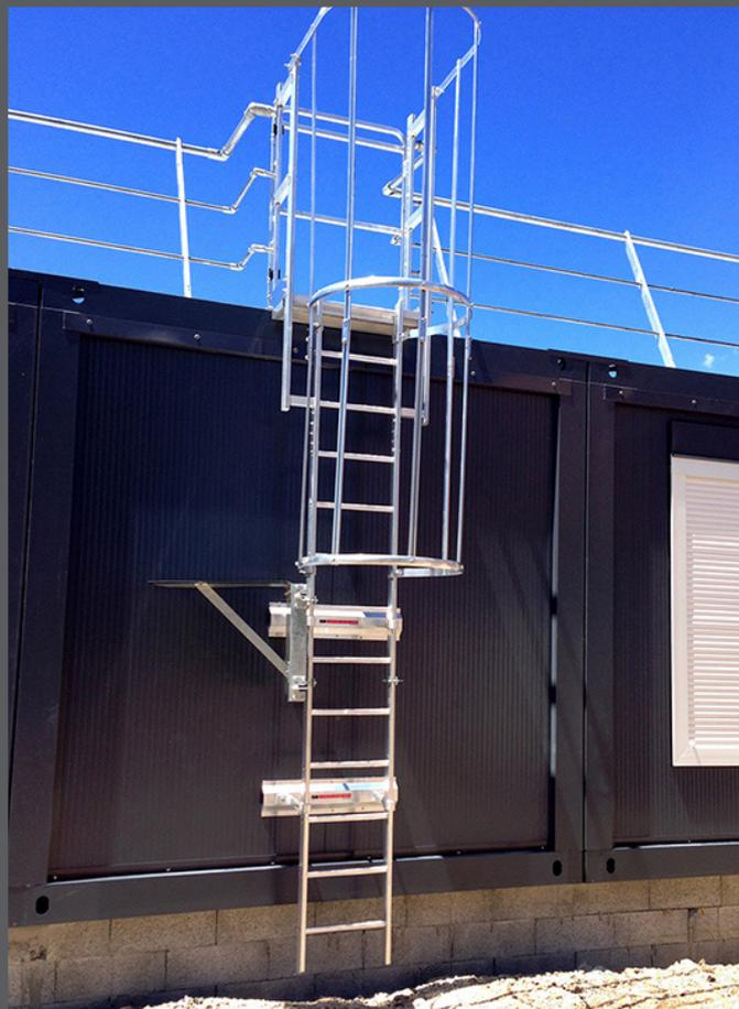
A gauche: Echelle alu de 9M sur bardage avec changement de volée (sortie de face avec palier de passage d'acrotère).
