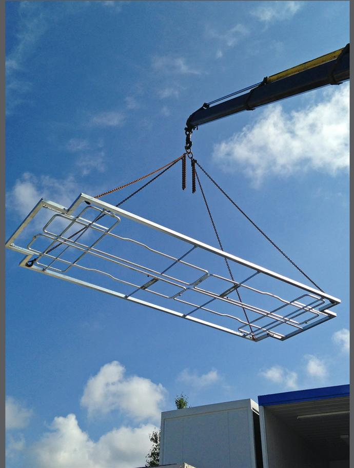
Intervention sur toiture à gauche. Elingage d'un Modulogard version 9 m à droite. En bas, Modulogard version 6 m en n+2.
