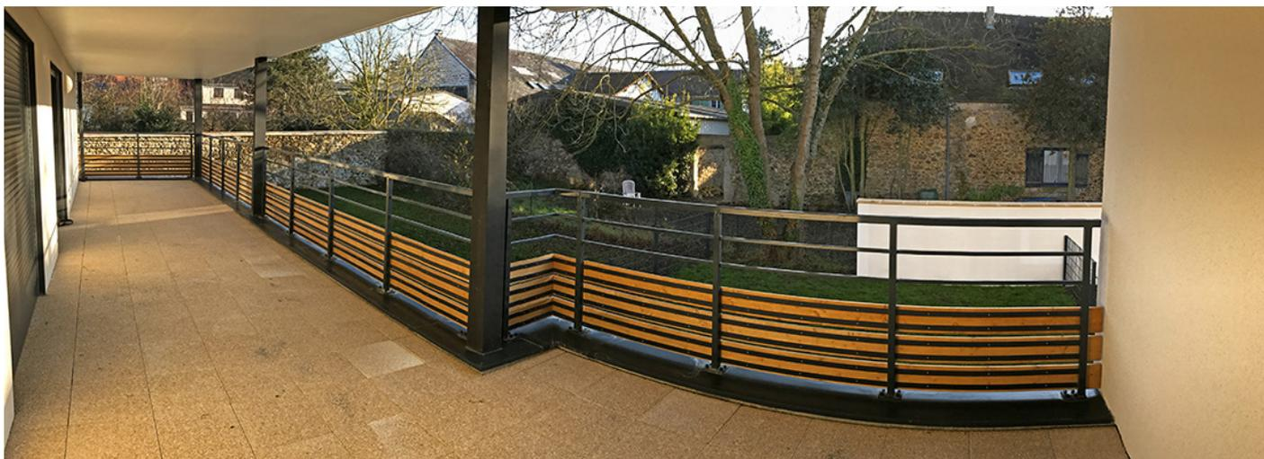
Garde-corps de terrasse accessible en tube acier thermolaqué. Soubassement en bois exotique en raccord avec la façade. Fixation sur dalle.
