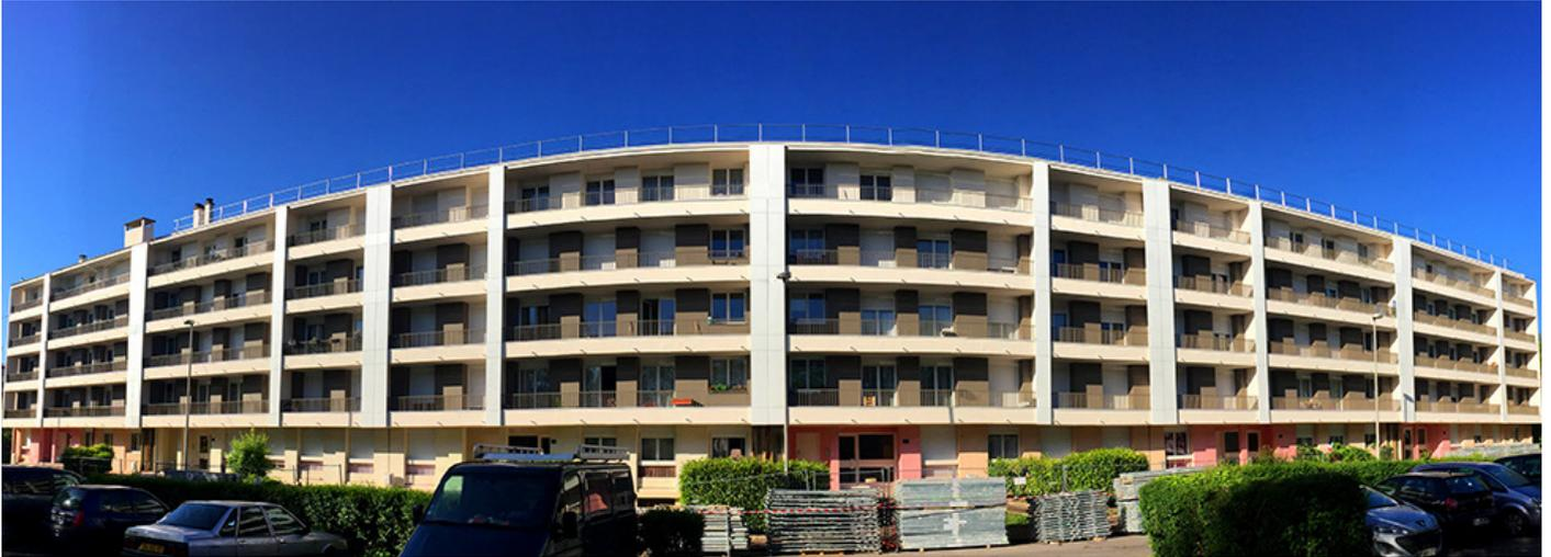
Réhabilitation complète de 720 balcons sur 5 bâtiments en garde-corps métalliques tubes barreaudés thermolaqués. Protection de 3000 ml de garde-corps de toiture terrasse Olystab autoportant aluminium. En accès rue sur les bâtiments: Garde-corps ERP rampants sur rampe handicapé et main courante sur partie murale. Protection du muret par garde-corps en applique.
