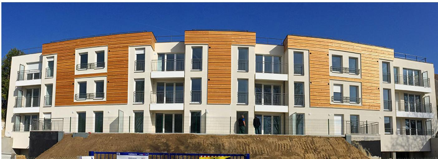
Immeuble d'habitation équipé en toiture terrasse de garde-corps non accessible au public. Pour les balcons et fenêtres, un garde-corps Gardotrad en éléments barreaudés en acier galvanisé thermolaqué (fixations sur acrotère et en applique).
