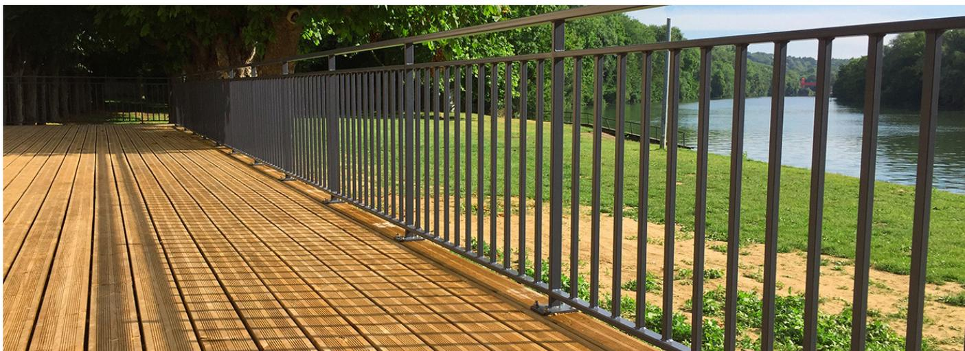
Garde-corps ERP classique barreau en acier tube 40x40 pré-galvanisé. Espacement entre barreaux 110mm. Fixation sur le dessus de dalle. Rampart fixé sur dessus de marche.
