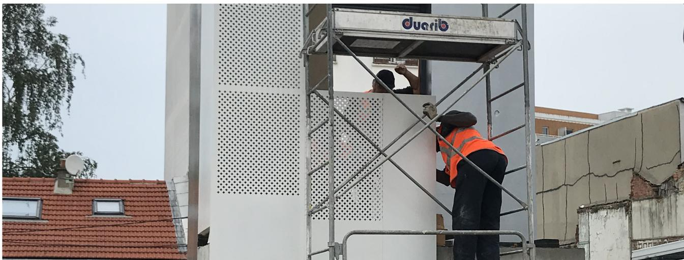
Prototype de façade pour immeuble regroupant l'ensemble des solutions proposées par ACBI, soit: Garde-corps acier ERP et pare-vue de façade en tôle perforée(perforations personnalisées, thermolaquage blanc et noir).
