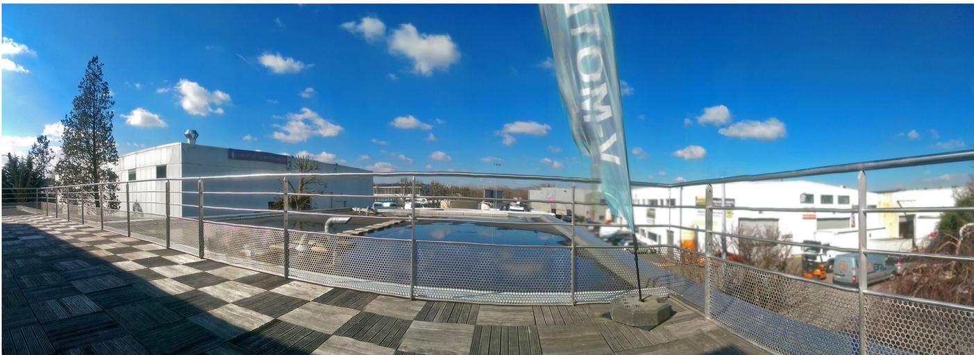
Transformation d'une terrasse inaccessible en terrasse accessible, protégée par du garde-corps public standard. Main courante Ø30 + partie basse en tôle perforée R10-t15. Traitement de surface par galvanisation à chaud.
