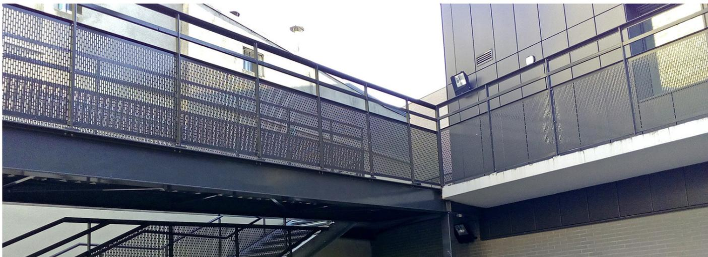
Passerelles et escaliers métalliques équipés de garde-corps en tôle découpée au laser avec une maille rectangulaire spécifique, non disponible en perforation.
