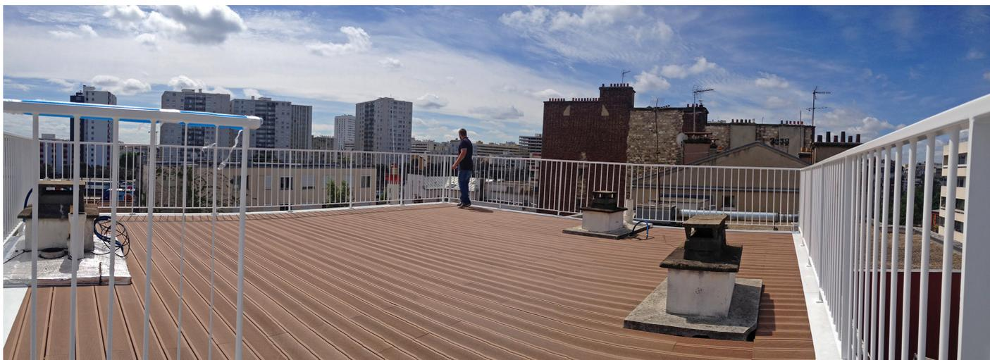
Garde-corps vintage sur bâtiment classé année 50. Barreaudage en rond Ø16 soudé dessus/dessous. Main courante et sous-lisse. Traitement de surface par thermolaquage blanc.
