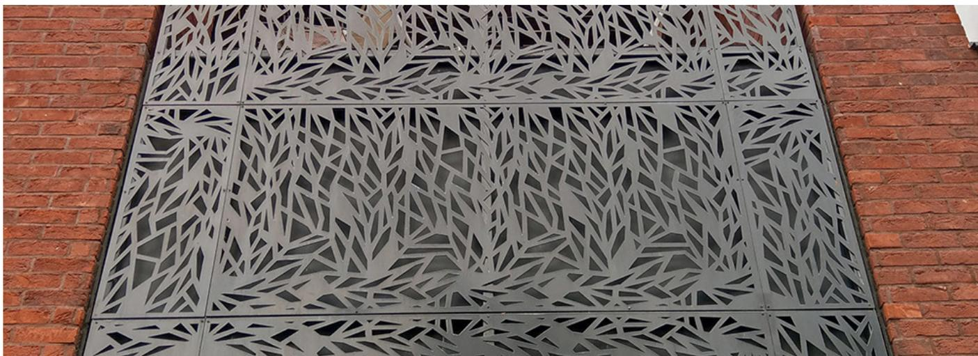
Garde-corps décoratifs: Tôle acier découpée au laser suivant motif de l'architecture, fixée sur structure métallique. Déclinée en garde-corps et pare-vue, finition thermolaquage gris anthracite.
