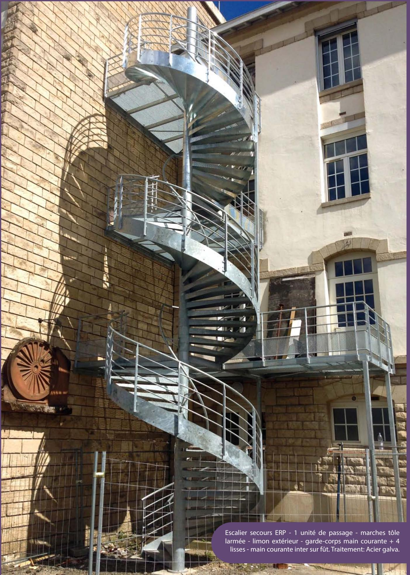
Escalier secours ERP - 1 unité de passage - marches tôle larmée - limon extérieur - garde-corps main courante + 4 lisses - main courante inter sur fût. Traitement: Acier galva.
