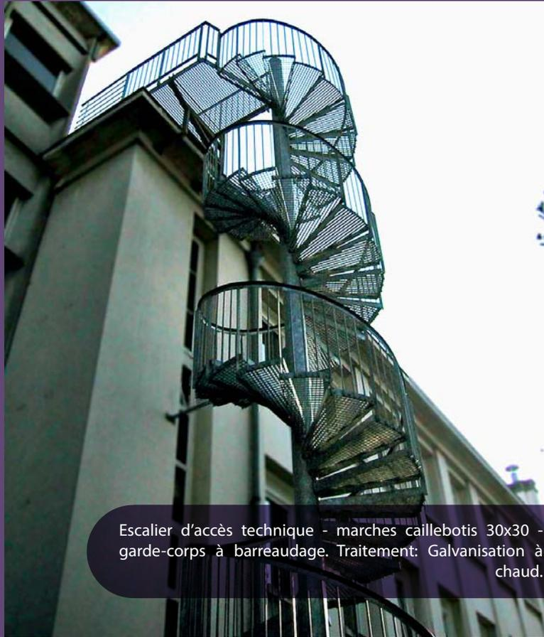
Escalier d'accès technique - marches caillebotis 30x30 - garde-corps à barreaudage. Traitement: Galvanisation à chaud.
