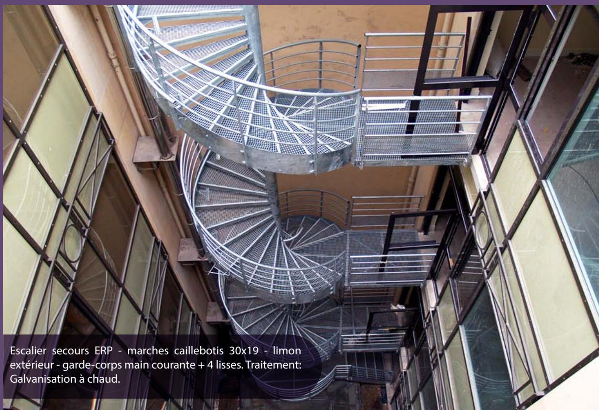
Escalier secours ERP - marches caillebotis 30x19 - limon extérieur - garde-corps main courante + 4 lisses. Traitement: Galvanisation à chaud.
