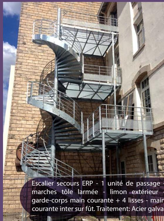
Escalier secours ERP - 1 unité de passage - marches tôle larmée - limon extérieur - garde-corps main courante + 4 lisses - main courante inter sur fût. Traitement: Acier galva.
