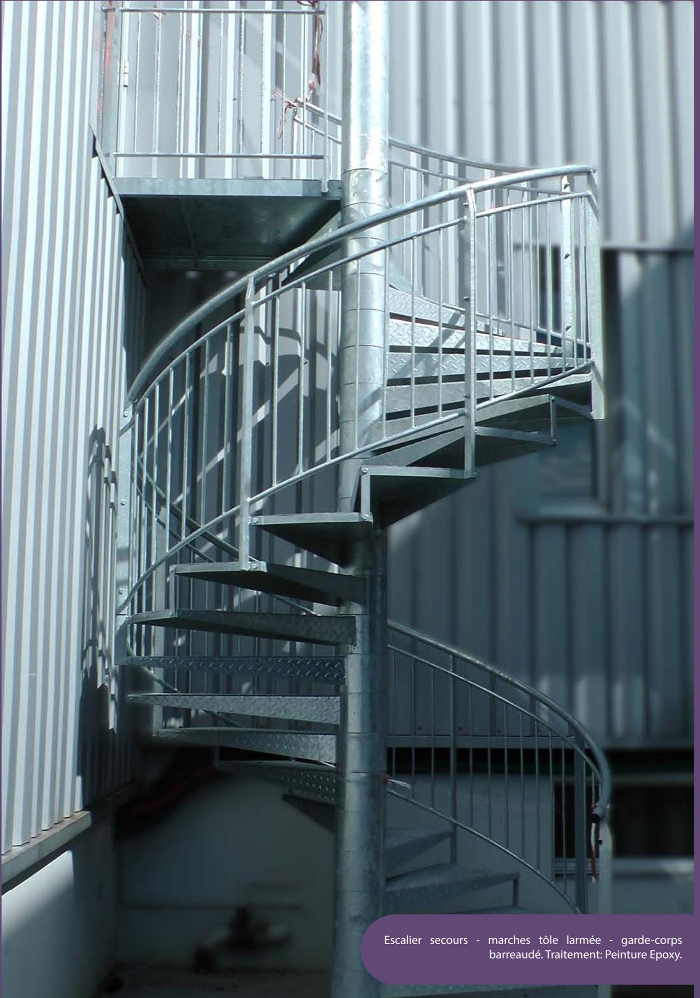
Escalier secours - marches tôle larmée - garde-corps barreauté. Traitement: Peinture Epoxy.
