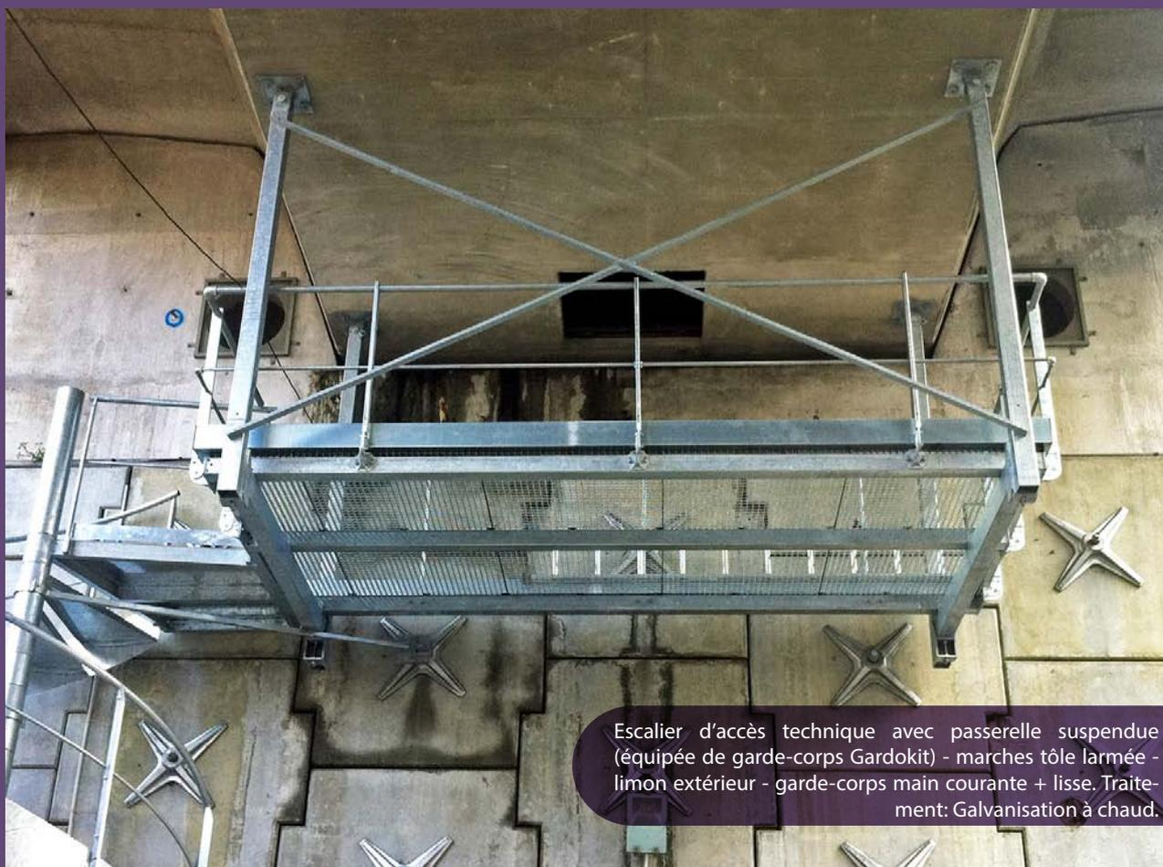
Escalier d'accès technique avec passerelle suspendue (équipée de garde-corps Gardokit) - marches tôle larmée - limon extérieur - garde-corps main courante + lisse. Traitement: Galvanisation à chaud.
