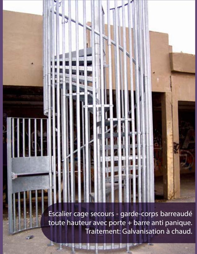
Escalier cage secours - garde-corps barreauté toute hauteur avec porte + barre anti panique. Traitement: Galvanisation à chaud.
