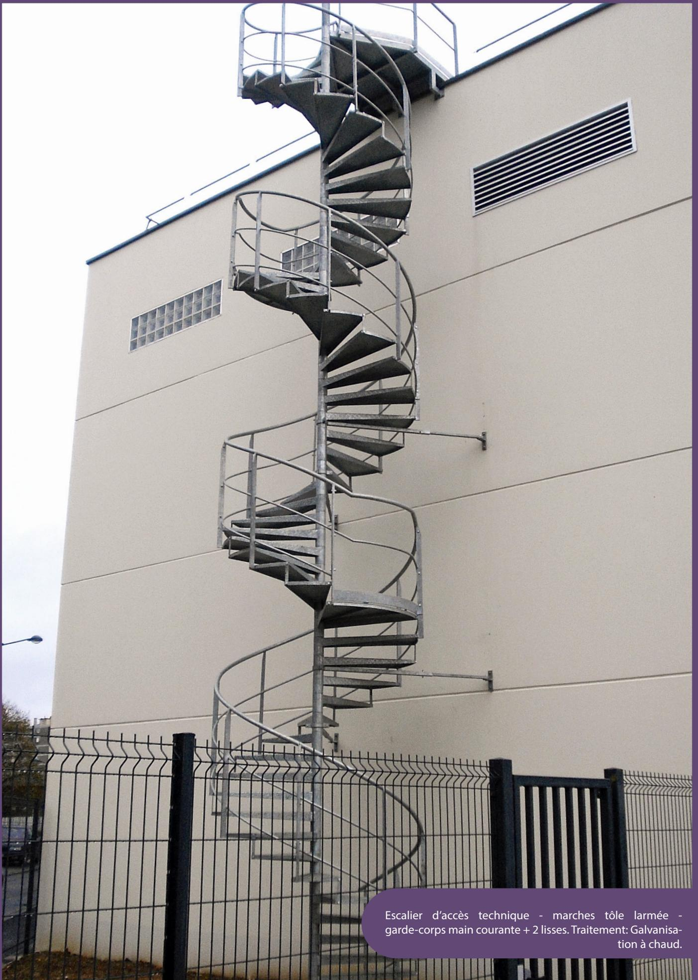
Escalier d'accès technique - marches tôle larmée - garde-corps main courante + 2 lisses. Traitement: Galvanisation à chaud.
