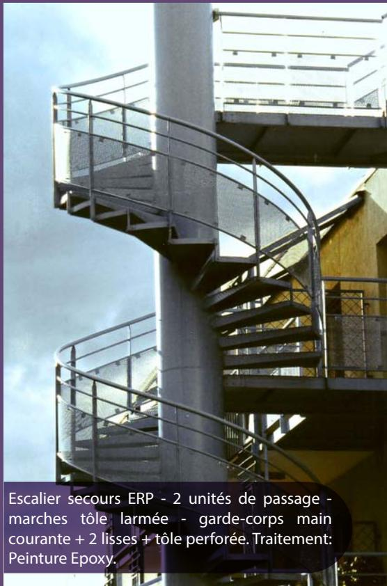
Escalier secours ERP - 2 unités de passage - marches tôle larmée - garde-corps main courante + 2 lisses + tôle perforée. Traitement: Peinture Epoxy.
