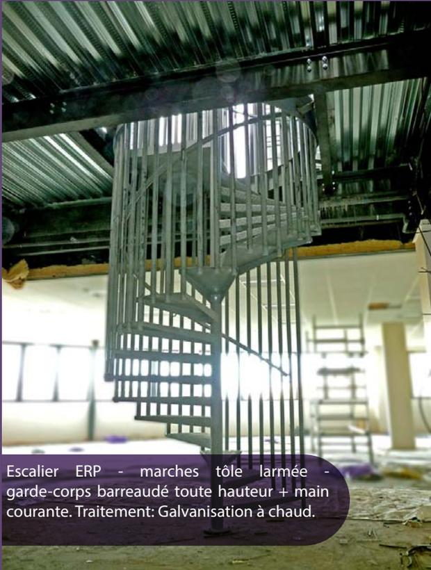
Escalier ERP - marches tôle larmée - garde-corps barreauté toute hauteur + main courante. Traitement: Galvanisation à chaud.
