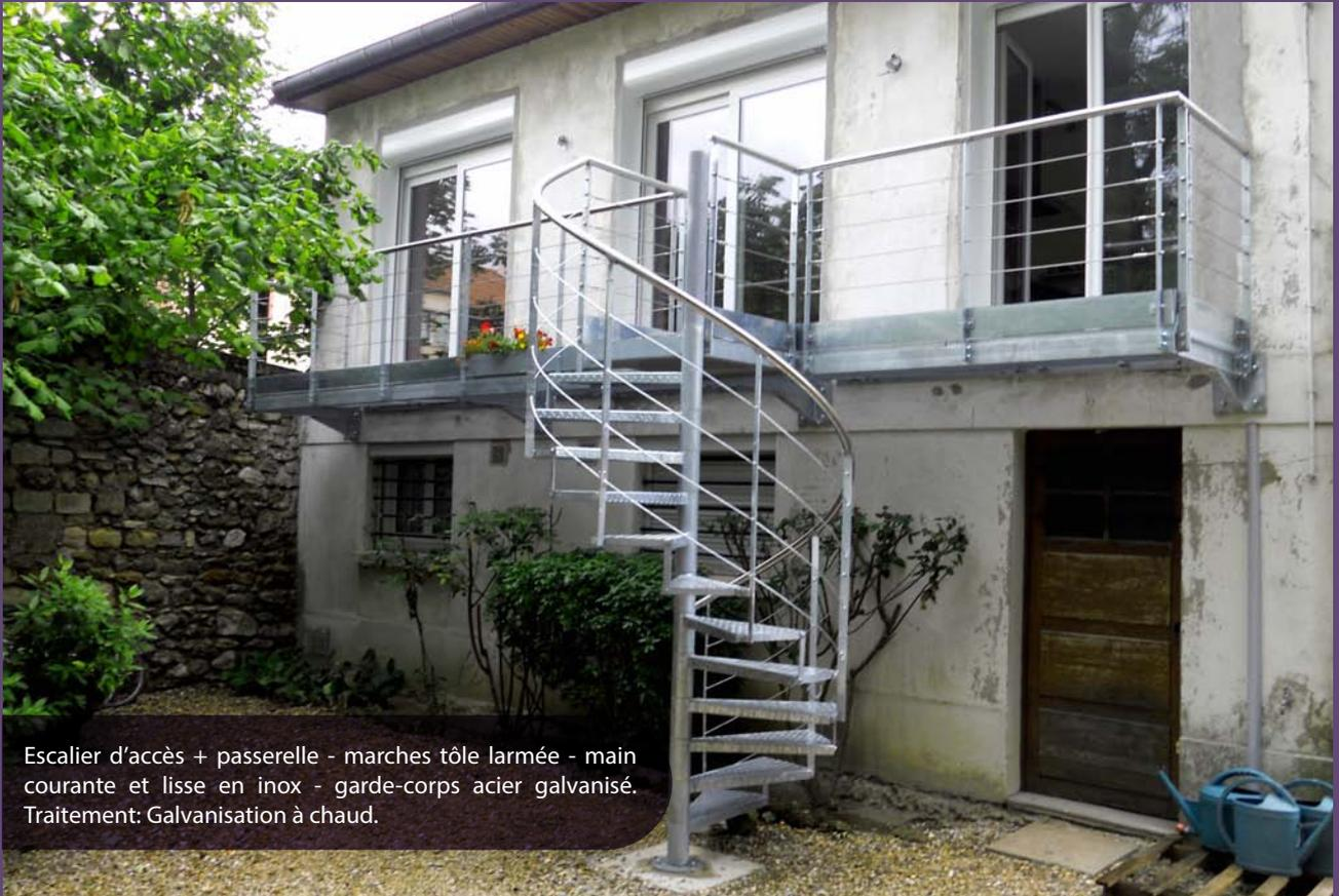
Escalier d'accès + passerelle - marches tôle larmée - main courante et lisse en inox - garde-corps acier galvanisé. Traitement: Galvanisation à chaud.
