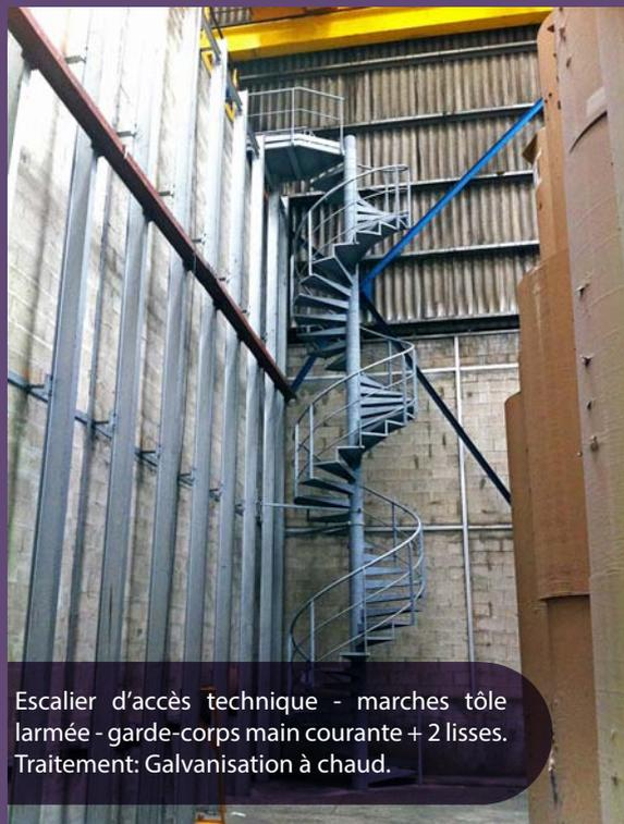
Escalier d'accès technique - marches tôle larmée - garde-corps main courante + 2 lisses. Traitement: Galvanisation à chaud.
