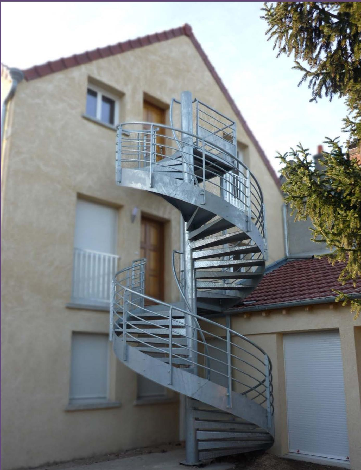
Escaliers d'accès ERP- marches tôle larmée - Main courante + 4 lisses - limon extérieur - main courante intérieure sur fût.
